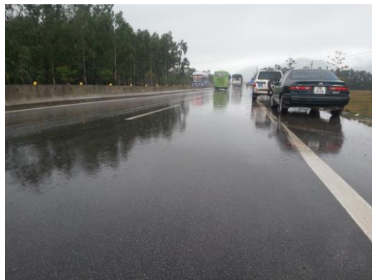
Hình 3. Cùng một đoạn tuyến, vẫn có những đoạn mặt đường không bị hằn lún vệt bánh xe (ảnh chụp QL1 đoạn Vinh- Hà Tĩnh ngày 13 tháng 6 năm 2014)
