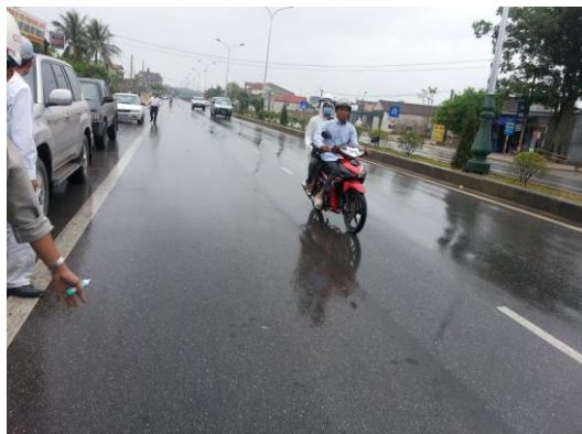
Hình 3. Cùng một đoạn tuyến, vẫn có những đoạn mặt đường không bị hằn lún vệt bánh xe (ảnh chụp QL1 đoạn Vinh- Hà Tĩnh ngày 13 tháng 6 năm 2014)
